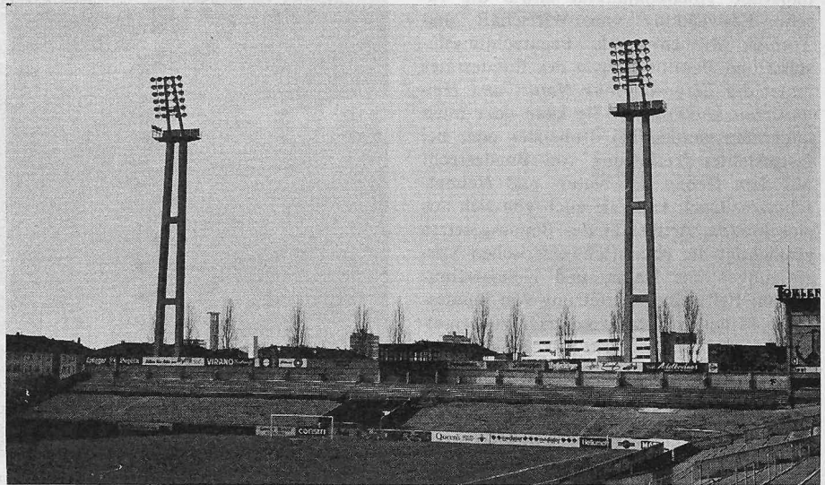
Bild 1. Stadion Wankdorf, Bern: Beleuchtungsmasten (50 m hoch). Einfache, das Stadtbild möglichst wenig störende Form
