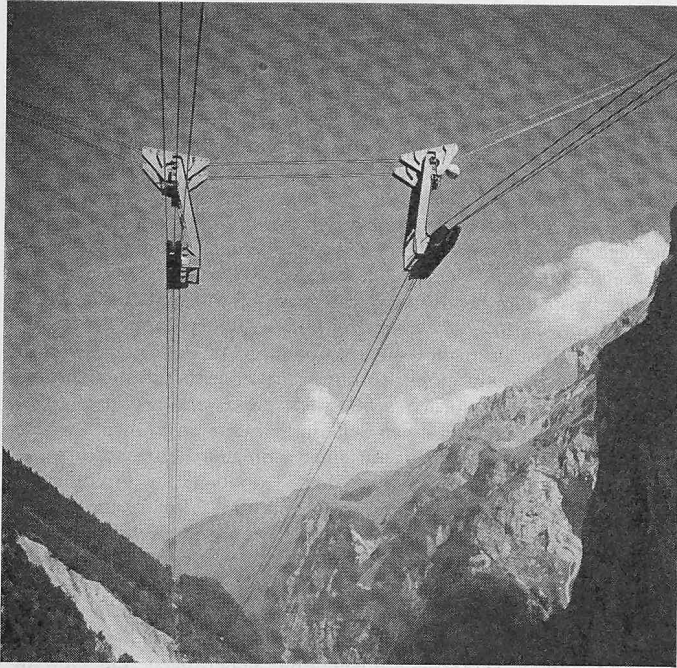
Bild 3. Einzelheit der Hängestütze Sandalp
