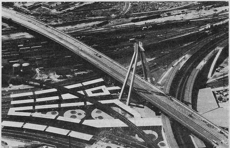
Bild 1. Hochstrasse im Bereich des neuen Ludwigshafener Hauptbahnhofs. Die gesamte Brückenanlage wurde von der Rheinstahl Union AG, Dortmund, gebaut
