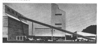
Über ein Transportband von 80 m Länge kann stündlich 600 m³ Material von der Entladegosse (Bahn- und Autobeschickung) in die Siloanlage transportiert werden.
