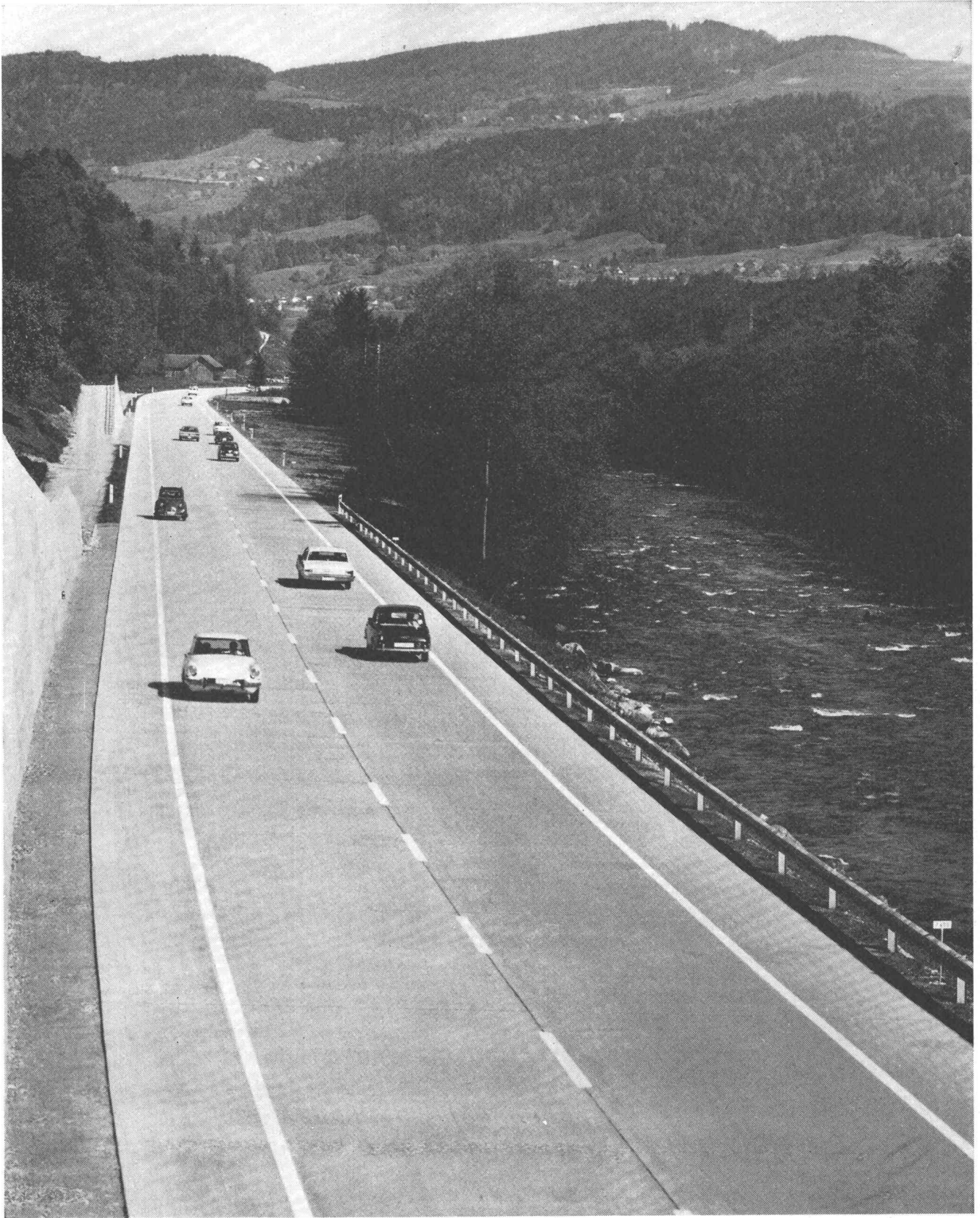
T 10, Bern—Luzern, Umfahrung Malters LU, Betonbelag
