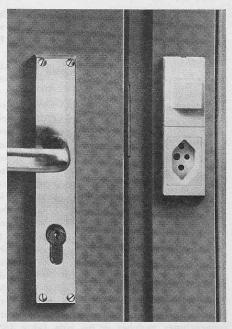
Bild 2. Druckschalter und Steckdose in der Türzarge
