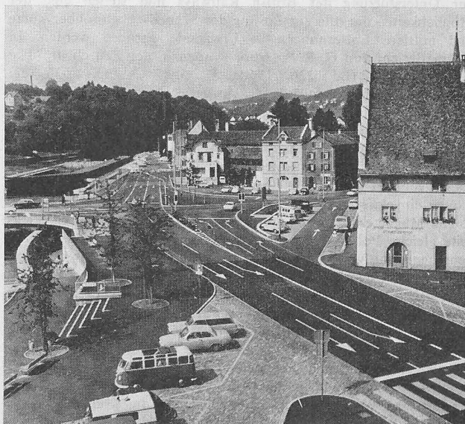
Bild 2. Freier Platz und Brückenkopf, Zustand Sommer 1968
