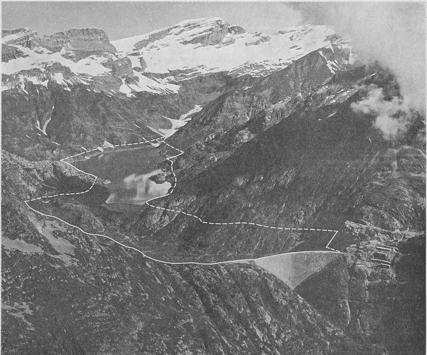
Bild 1. Gesamtansicht des Speichers Emosson von der Luftseite. Im Hintergrund der alte Stausee Barberine der SBB, im Vordergrund rechts ein Teil der Installationen für den Bau der Staumauer
