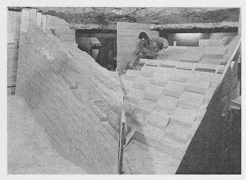
Bild 10. Luftseitige Ansicht des geomechanischen Modells 1:100 während des Baues. Die steil stehenden Hauptklüfte wurden durchgehend dargestellt, während die flach liegenden Nebenklüfte um je 50 % versetzt wurden
