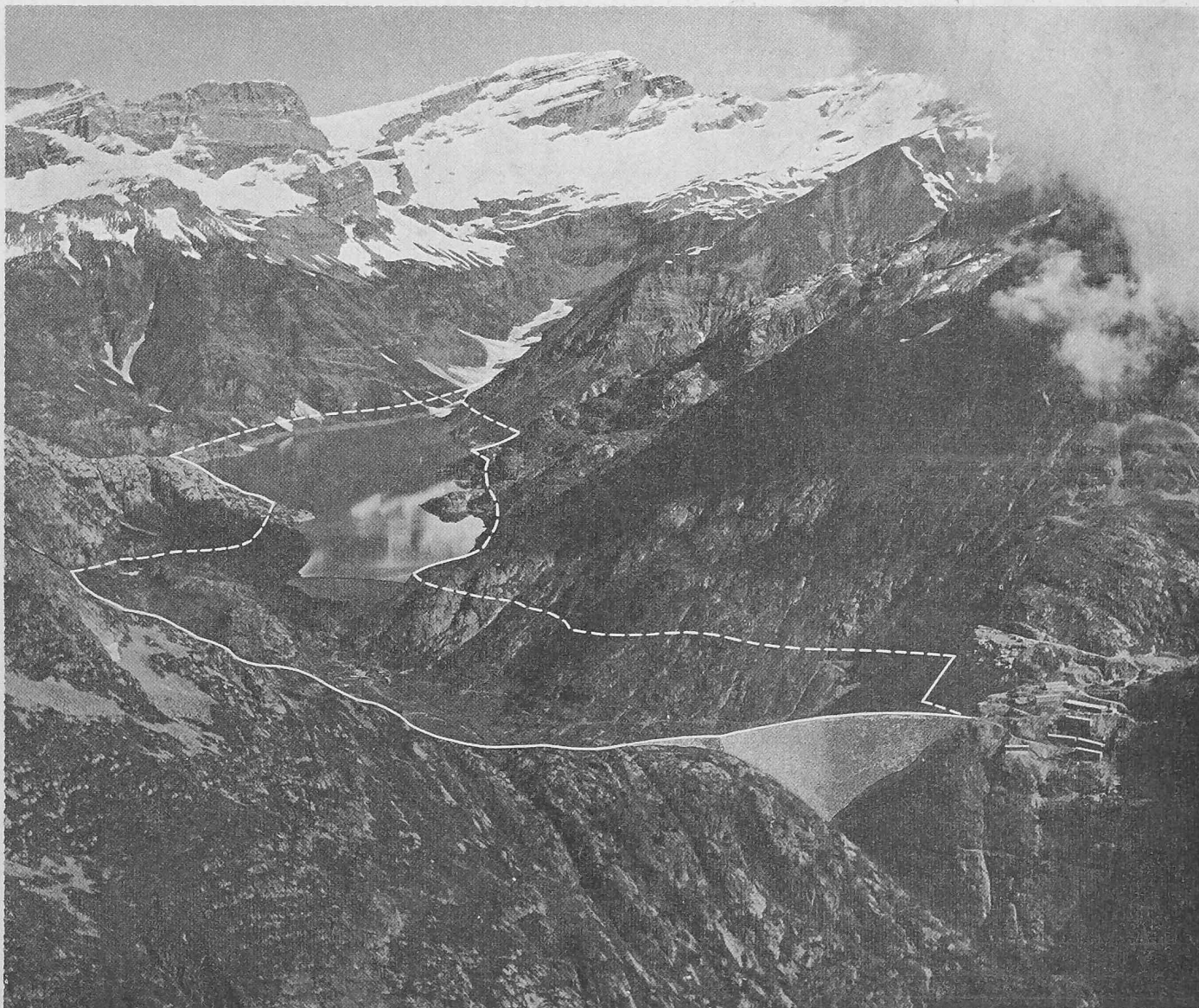
Bild 1. Gesamtansicht des Speichers Emosson von der Luftseite. Im Hintergrund der alte Stausee Barberine der SBB, im Vordergrund rechts ein Teil der Installationen für den Bau der Staumauer
