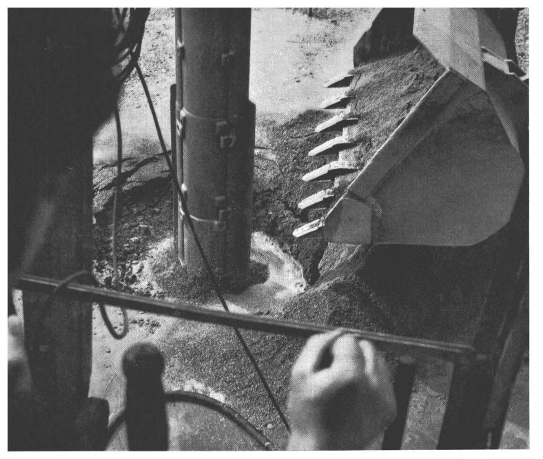
Tiefenverdichtungen nach dem **Rütteldruckverfahren.** Zur Erhöhung der Tragfähigkeit anstehender Böden oder künstlicher Aufschüttungen. Zur Reduktion der Wasserdurchässigkeit (k-Wert) grobdurchlässiger Kiese und Kiessande.
