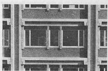
Bild 4 (I.). Innenstütze mit Unterzugsauflager und Deckenplatten. Allseitig Aussparungen für einfache vertikale Installationen
