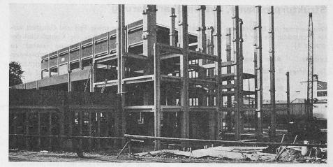
Bild 2 (I.). Konstruktives Gerippe, in welches beliebige Fassadenelemente eingebaut werden können
