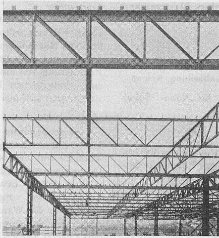
Bild 2 (r.). Fassadenausschnitt der Maschinenfabrik Agathon. Alle Einzelemente und die vertikalen Wandstiele sind demontierbar und austauschbar mit Lüftungselementen und Toren (USM Maxi-Stahlbausystem «Haller»)
