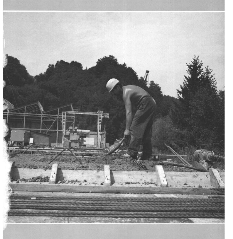
Warum reduzieren die Vibrationsnadeln VIBROFLUX die Betonier-Kosten?
