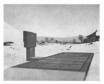
Brücke 10×2,8 m, Laufgewichtsbalken mit parallelgeschaltetem Messkopf
