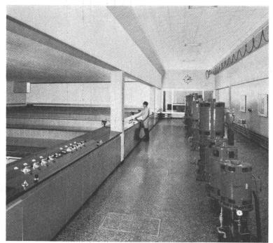
Schnellfilteranlage «Champ-Bougin» der Stadt Neuenburg für das Aufbereiten von Seewasser zu Trinkwasser. Leistung 1800 m³/h
