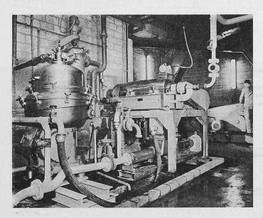
Bild 7. Provisorium zur Zentrifugierung des Schlamms; rechts 1. Stufe, links 2. Zentrifugierungsstufe  $\circ$
