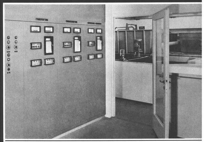
Vollautomatische Durchlaufanlage bei der Firma Adolf Feller AG, Horgen, zur Cyanidoxydation, Chromatreduktion, Nitritoxydation und Neutralisation.
