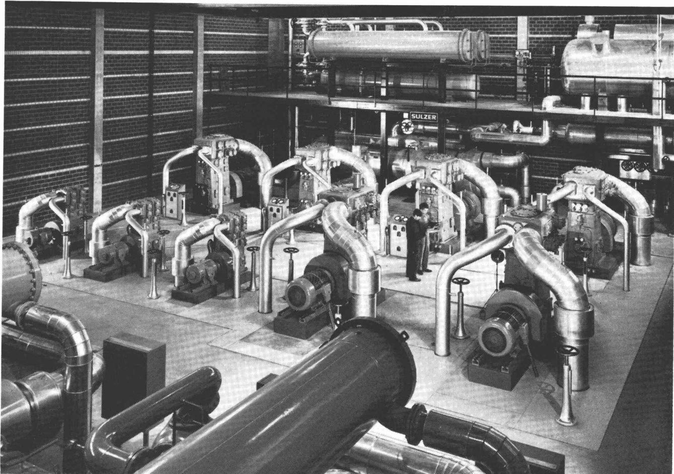
«Ölfreie Kälteanlage in einem chemischen Produktionsbetrieb in der Schweiz mit 5 einstufigen und 4 zweistufigen Labyrinthkolben-Kompressoren, für die Erzeugung von Kälte für verschiedene Zwecke bei Verdampfungstemperaturen von  $-60^\circ$ ,  $-48^\circ$  und  $-36^\circ$  C.
