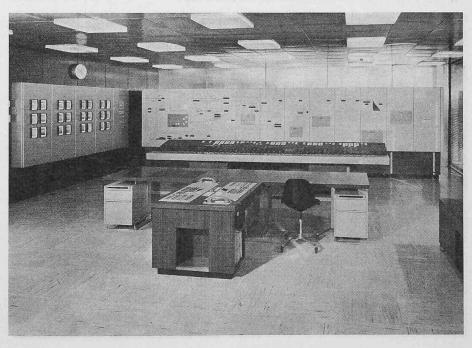
par 6 canaux de télémesure digitaux et cycliques ainsi qu'un grand nombre de signaux transmis par 4 voies de télésignalisation. Un tableau synoptique (fig. 1) présente à l'exploitant les valeurs actuelles de toutes les mesures hydrauliques et un pupitre toutes celles des valeurs électriques. Le même pupitre permet la commande manuelle à distance de tous les groupes équipant les usines, ceci par le moyen de quatre canaux de télécommande.
