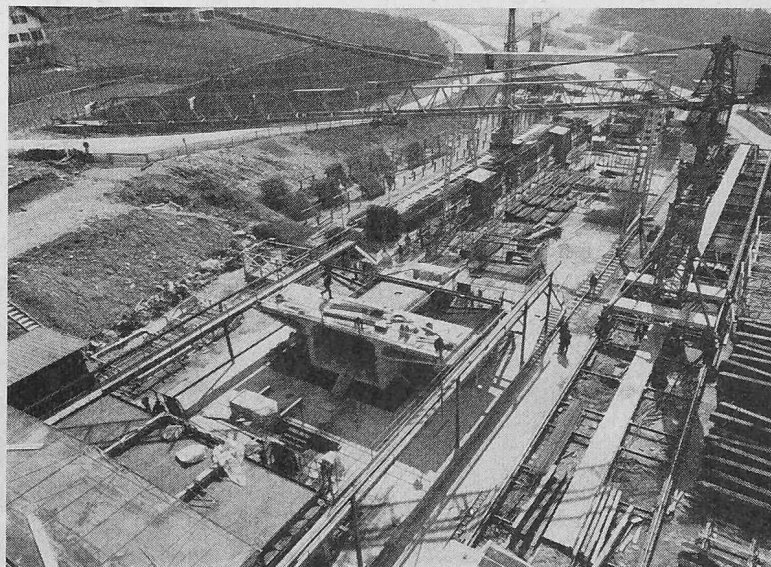
Bild 7. Sicht auf die Vorfabrikationsgruben und vorbereitete Armierungseinheiten
