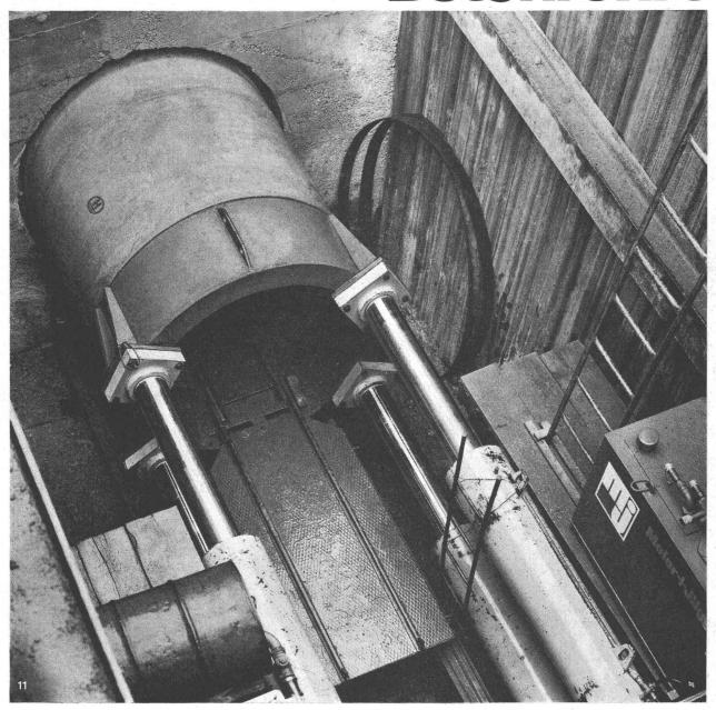
Gestern noch wurden Betonrohre fast ausschliesslich im offenen Graben verlegt. Heute hilft eine neue Technik, wenn Leitungsgräben besondere Schwierigkeiten bieten: Hydraulische Pressen stossen die Rohre durch das Erdreich - selbst unter Strassen, Bahngeleisen und Häusern hindurch...
