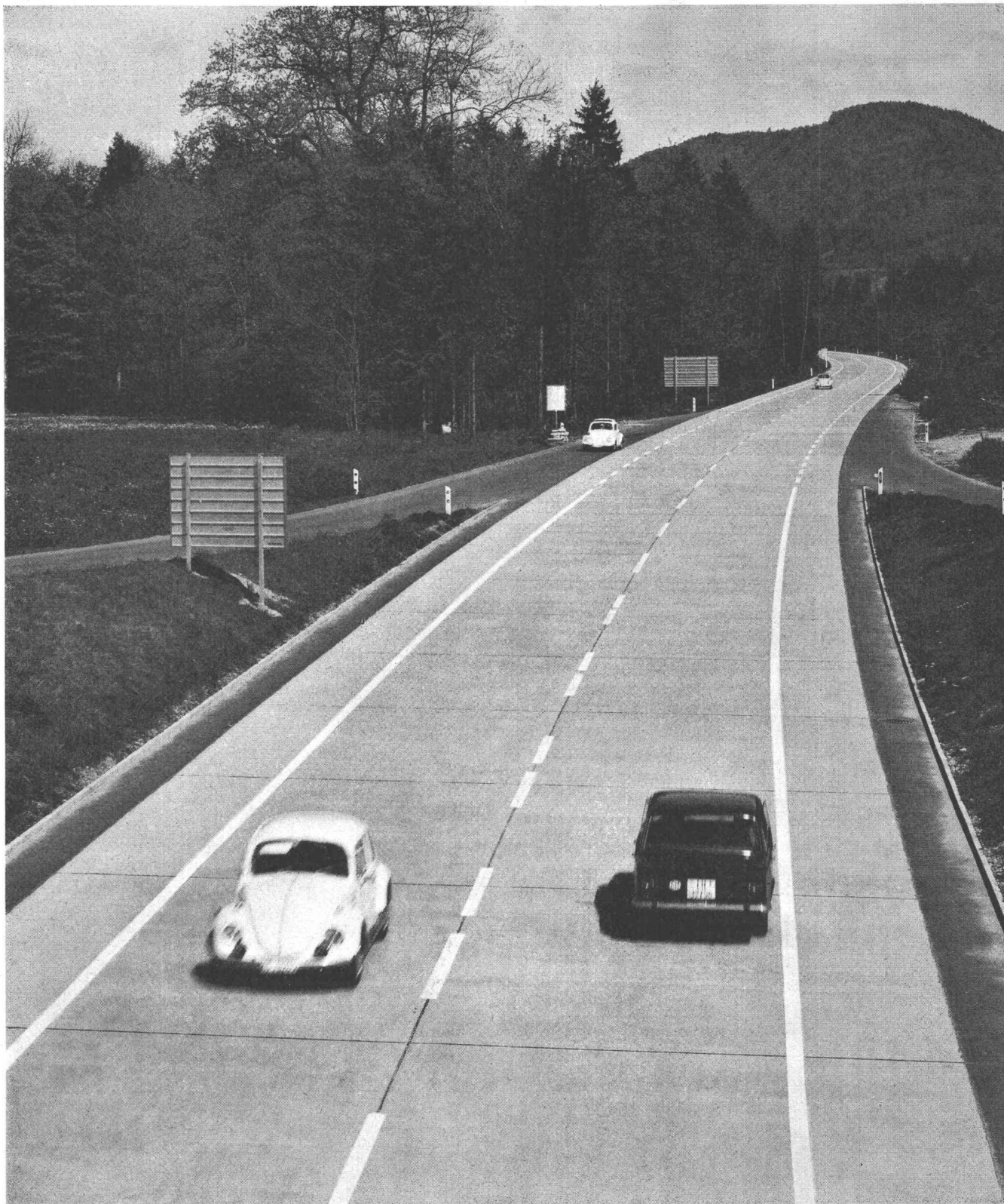
T 10, Luzern—Bern, Umfahrung Malters, Betonbelag
