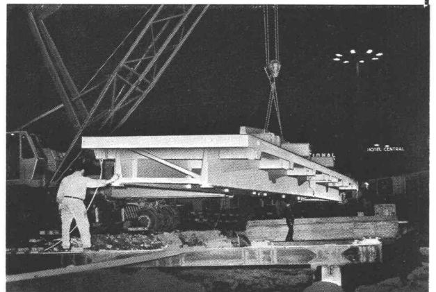
Stahlhochstrasse, System «Rheinstahl», auf dem Bahnhofplatz in Zürich. Länge 36 m, zweispurig. Dauer der nächtlichen Montage: 4 Std.
