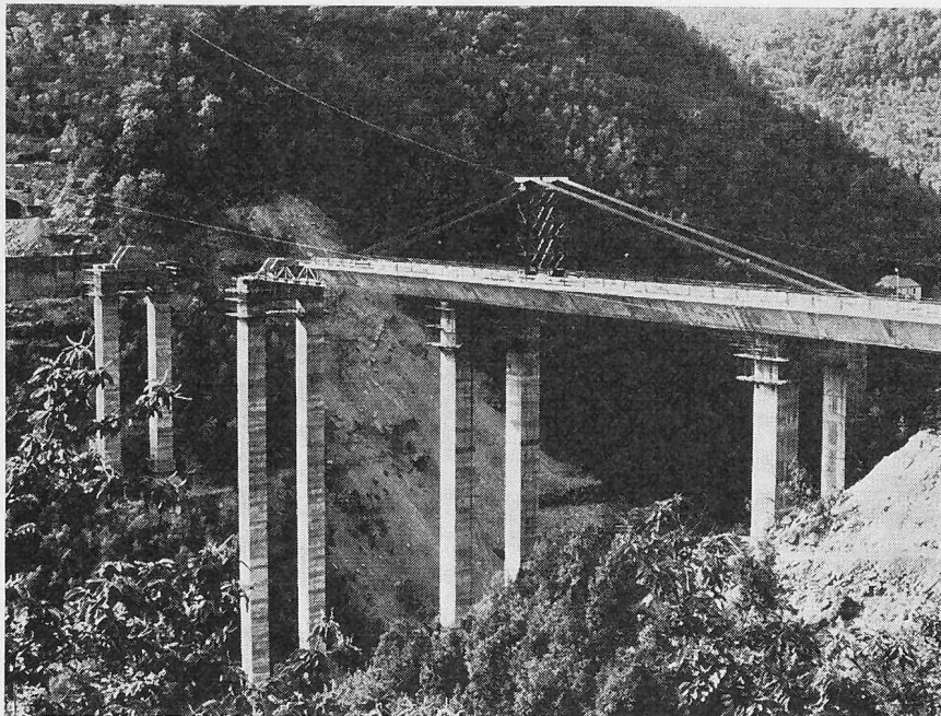
Bild 5. Abspannturm und Vorbauseisengerüst
