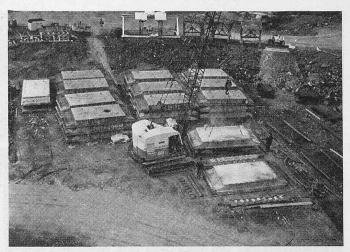
Bild 9. Abheben der Kassettendeckenelemente mit Fahrzeugkran
