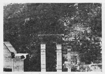
Bild 8. Betonieren der 80,0 m langen Pfeiler mit Gleitschalung
