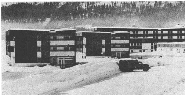
Frankreich — Olympisches Dorf Grenoble Bessere Raumklima-Gestaltung: Roofmate fand im Olympischen Dorf in Grenoble ausgedehnte Verwendung, weil es die Aufrechterhaltung eines angenehmen Raumklimas in den Wohnquartieren erleichterte. Diese Anforderung wird bei industriellen, kommerziellen und Wohnbau-Projekten immer wichtiger. Roofmate — ein Produkt höchster Qualität — bietet Gewähr, dass diese hohen Anforderungen während der ganzen Lebensdauer des Gebäudes erfüllt bleiben.
