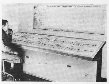
Bild 7. Das Fernsteuer- und Überwachungspult für die Strecke Brig-Visp-Zermatt im Verwaltungsgebäude der Brig-Visp-Zermatt-Bahn in Brig
