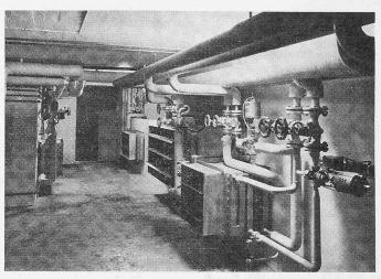
Bild 31b. Blick in die Zuluftkammer im Geschoss C zur Klima-Unterzentrale mit den Geräten für die Nachbehandlung der Zuluft. Links: gemauerter Kasten mit vorgebauten Kühlern und Nachwärmern für die Zuluft zum Tauschvorrat (vorn) und Büchermagazin C (hinten, nicht sichtbar). Rechts: Nachwärmer für Büchermagazin B (hinten), Nachwärmer für Büchermagazin A (Mitte), Kühler und Nachwärmer für den Aufenthaltsraum (vorn). Allen Zuluft-Eintritten sind Regulierklappen vorgeschaltet
