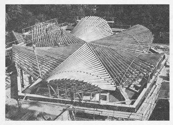
Bild 25. Schalungskonstruktion für die Betonschale über dem grossen Lesesaal, Verlegen der Sparrenlage zur Aufnahme der Bretterschalung
