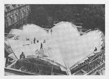
Bild 26. Die Bretterschalung wird in Richtung der Erzeugenden der Regelfläche verlegt (geringer Verschnitt)
