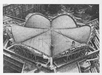
Bild 27. Montage des Armierungsnetzes
