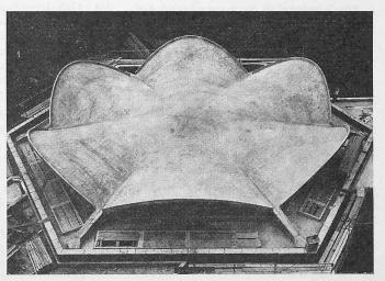
Bild 28. Die ausgeschalte Betonkuppel. Für das darüber zu erstellende Kaltdach wird die Bretterschalung als Unterlage für die Kupferabdeckung wieder verwendet
