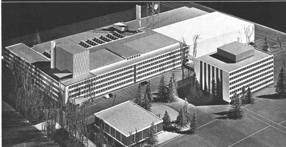
Fernsehstudio Leutschenbach, Zürich Architekt und Generalunternehmer: Ernst Göhner AG, Zürich
