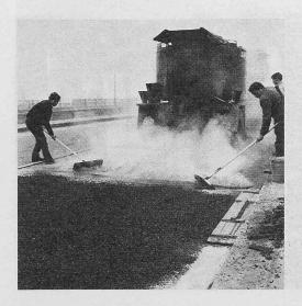
Bild 3 (links). Aufbringen eines dünnen Asphaltmastix-Überzuges mit Lucobit-Zusatz
