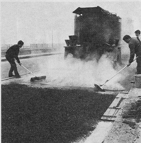
Bild 3 (links). Aufbringen eines dünnen Asphaltmastix-Überzuges mit Lucobit-Zusatz
