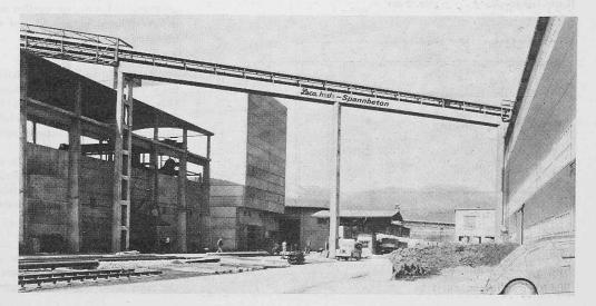
Bild 1. Die Transportband-Brücke aus Leca-hade-Spannbeton im Portlandcementwerk AG. Olten
