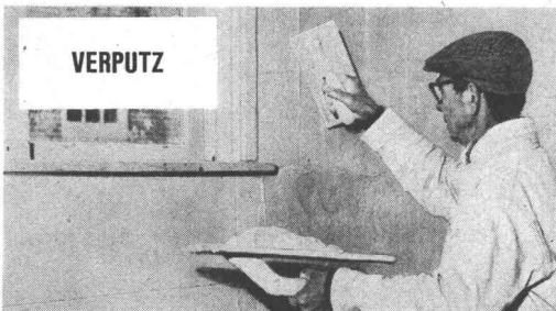
Styrofoam lässt sich ausgezeichnet mit allen gebräuchlichen Materialien verputzen. Pressplatten, Gipstafeln und Täfelungen können direkt darauf angebracht werden. Styrofoam wird mit Zementmörtel unmittelbar auf das Mauerwerk aufgeklebt. Dadurch senkt es Arbeitszeit und Arbeitskosten erheblich.
