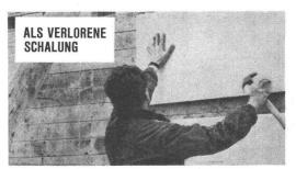
Die hohe Festigkeit von Styrofoam FR erlaubt die Verwendung als Schalung bei dünnschaligen Betonkonstruktionen. Durch seine Oberflächenstruktur verbindet es sich innig mit dem Beton.
