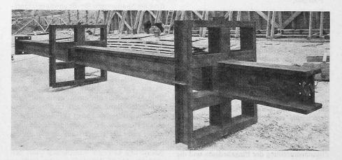
Bild 1. Stahlstütze mit angeschweissten Stahlpilzen
