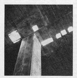
Bild 10. Flachdecke mit grossen Aussparungen im Stützenbereich
