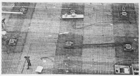
Bild 12. Flachdecken mit Stahlpilzen vor dem Betonieren
