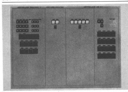
GUTOR-convertomat Wechselrichter für Leistungen von 0,25–10 kVA
