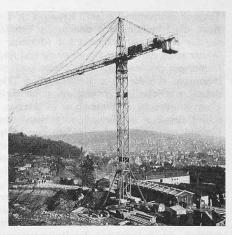
Bild 6. Der Wolff-Laufkatzenkran Form 60 S ist fertig montiert
