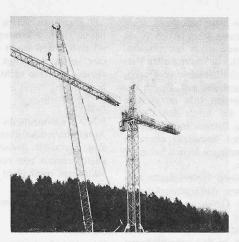
Bild 5. Montage des bereits am Boden zusammengesetzten Laufkatzenauslegers
