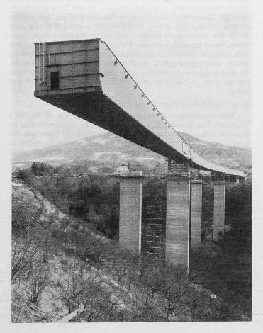
welche die Rollenbatterien tragen und auch zum nachfolgenden Absenken dienen. Das Absenken erfolgt in der Regel mit ölhydraulischen Pressen. Um diese handlich zu halten, muss ein nur kleiner Hub von 20 bis 30 cm in Kauf genommen werden. Hiedurch wird es nötig, die provisorischen Pfeileraufbauten so auszubilden, dass sie in kleinen Etappen abgebaut werden können.
