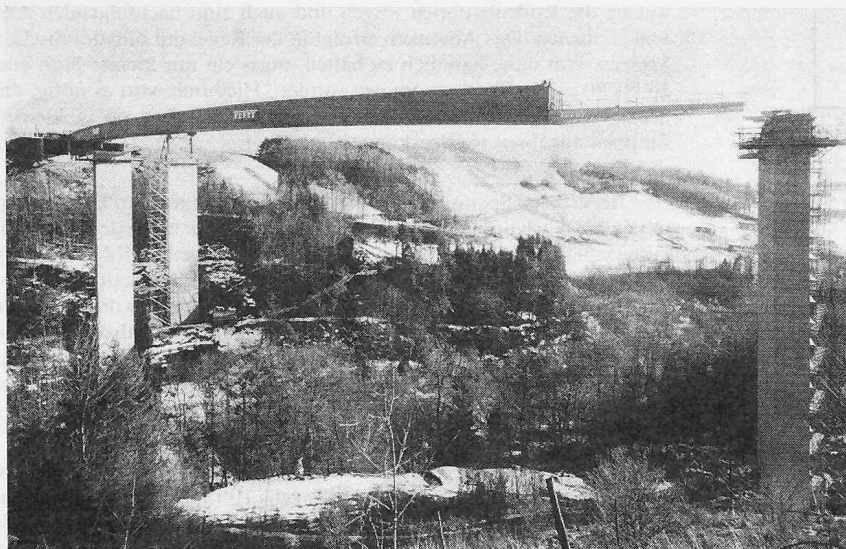
Bild 2. Autobahnbrücke über die Veveyse. Einschieben des kastenförmigen Stahlträgers über die Mittelspannweite von 129 m
