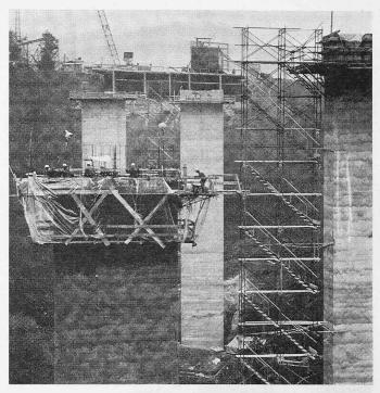
Bild 5. Brückenpfeiler, Kastenquerschnitt 2,20 m  $\times$  7,50 m, Höhe 50 m. Ziehleistung 5,50 m $^{\rm 1}$  je 24 Stunden
