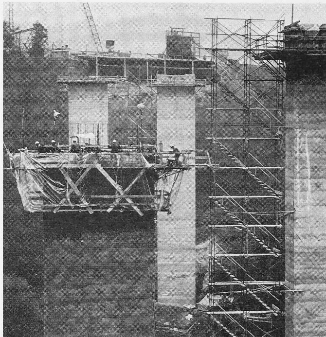
Bild 5. Brückenpfeiler, Kastenquerschnitt 2,20 \text{ m} \times 7,50 \text{ m} , Höhe 50 m. Ziehleistung 5,50 \text{ m}^3 je 24 Stunden
