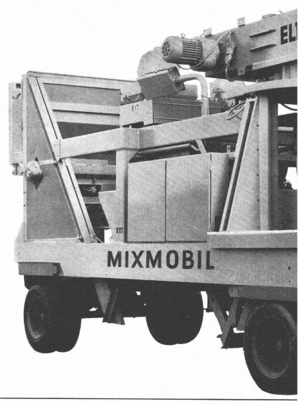
Stundenleistung 20-25 m³. Montage und Demontage kurzfristig ohne Kranhilfe. Alle Teile sind auf einem Rahmen vereint und anschlussfertig installiert. Elba-Zwangsmischer mit 4-Sekunden-Schnellentleerung garantiert Qualitätsbeton. Einige Hundert stehen bereits im Betrieb! Abgabemöglichkeiten wählbar in Krankübel, Betonpumpen, LKW, Dumper, Transportmulden. Keine Grube, Sichtkontrolle beim Mischvorgang.
