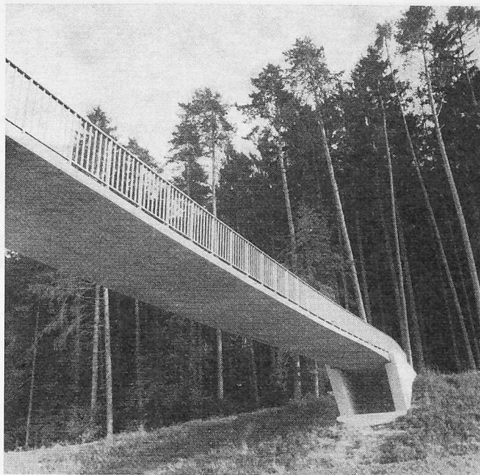
Bild 6. Untersicht und bergseitiges Widerlager (Linienabwälz-Lager) des Spannbandes Bircherweid
