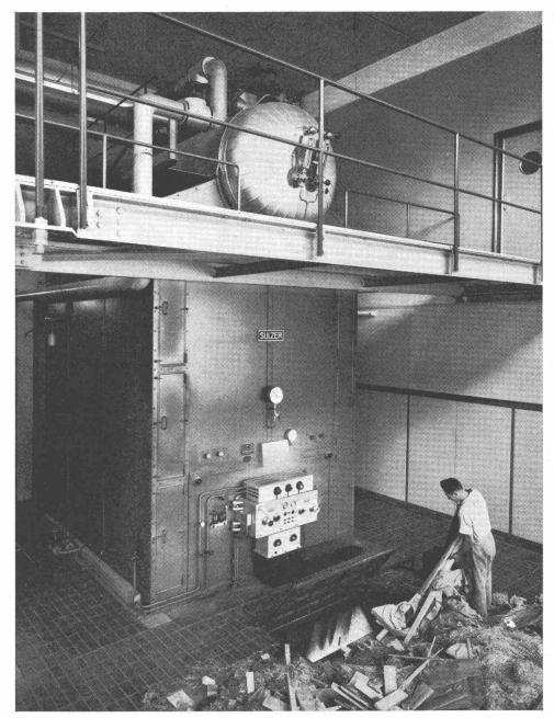
Ölgefeuerter Strahlungskessel Typ C mit einer Vorfeuerung zum Verbrennen von Abfällen. In dieser Anlage einer Maschinenfabrik sind noch zwei weitere Strahlungskessel Typ C aufgestellt. Alle drei Kessel sind für eine höchste Dauerleistung von je 5 t/h und einen Betriebsdruck von 13 atu ausgelegt.
