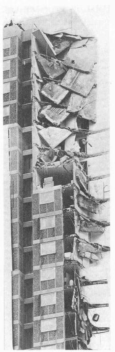
Bild 2. Oberer Teil, nach der Explosion, einige Zeit vor Bild 1 aufgenommen.
