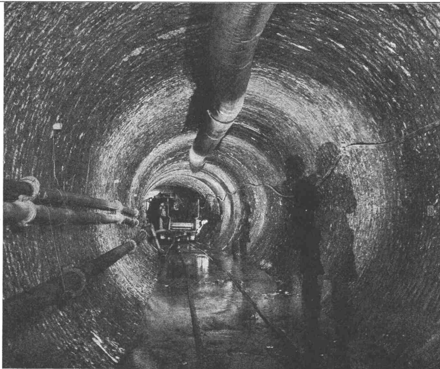
Druckwasserstollen Julia/Schweiz: Kurvenstrecke R=300 m Durchmesser 3,40 m
