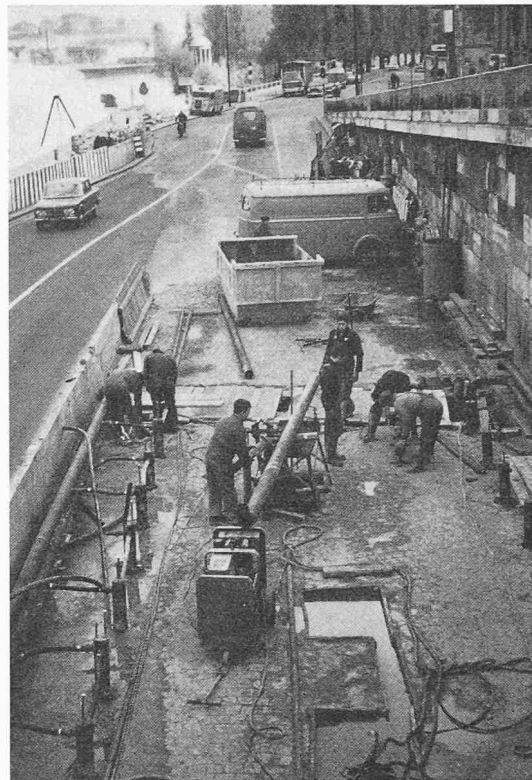
Figure 5. Aménagement de l'Hongrin-Léman, galerie d'adduction Est. Le jumbo rotatif et ses deux perforatrices, pour le forage et la mise en place des congélateurs (document S. I. F. — Photo Germond, Lausanne)
