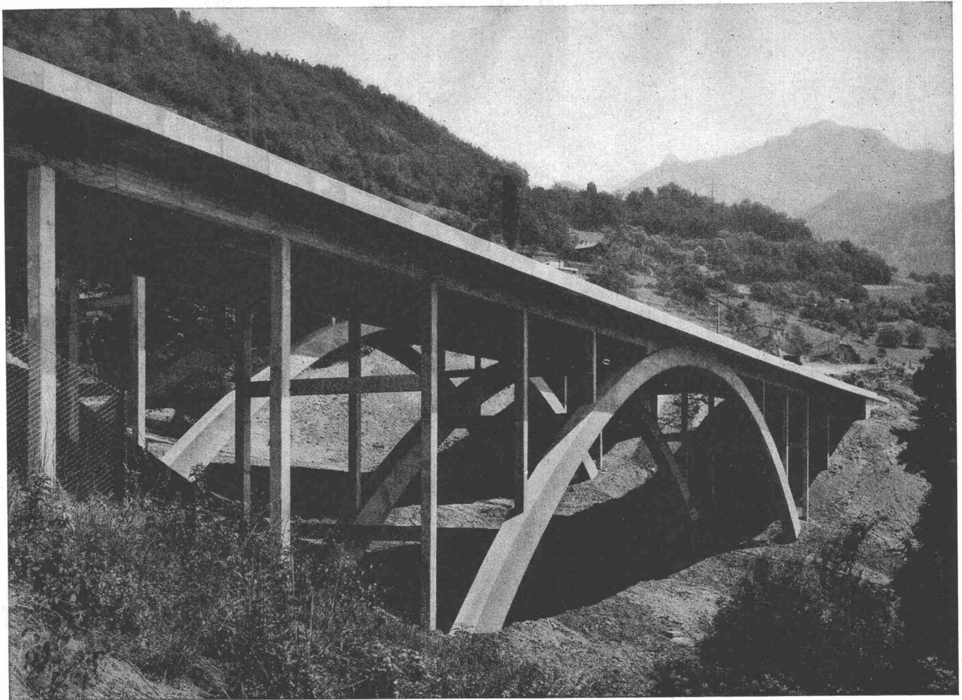
Autobahn N 9 Pont des Vuarennas, Chernex VD
