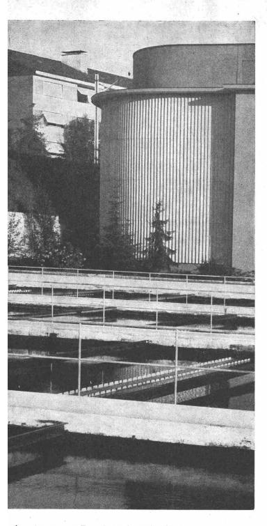
sbestzement-Produkte «ETERNIT» in der Abassertechnik. Rohre für Kanalisationen. Zakenüberfälle für Nachklärbecken. Spezialformtücke für Brückenentwässerungen. Wellplatten ir Verkleidung von Faulräumen.
