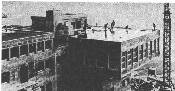
Schweiz — Bergstation Corviglia 2500 m.ü.M. Rauhes Klima: Roofmate wurde zur Dachisolation in der Bergstation Corviglia verwendet. Hier war wesentlich, dass Material verwendet wurde, das den schlimmsten Wetterverhältnissen widersteht.
