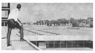
Schweiz – Flughafen Genf Verhinderung von Wärmedehnung: 10 000 m² Roofmate wurden im neuen Flughafengebäude Genf verlegt, weil es die bei Wärmedehnung auftretenden Spannungen in der Dachterrasse verhindert.
