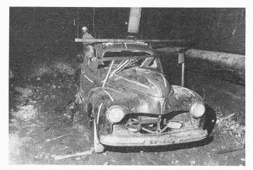
Bild 5. Benzindampf-Explosion in einem Strassentunnel
