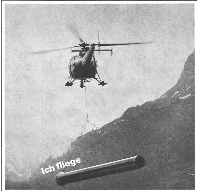
in unwegsame Gebiete. Heute in die Gegend von Zermatt, wo man die neue Wasserversorgung baut. Ein duktiles Gussrohr kann sich solche Flüge leisten. Denn es ist leicht an Gewicht. Beim Starten und Aufsetzen ist kein Bruch zu befürchten. Denn es ist bruchfest.
