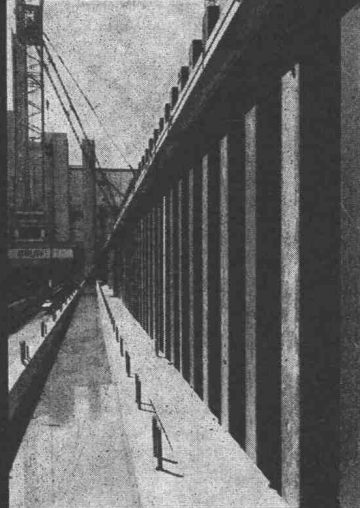
Spundwand Viscose Emmenbrücke
