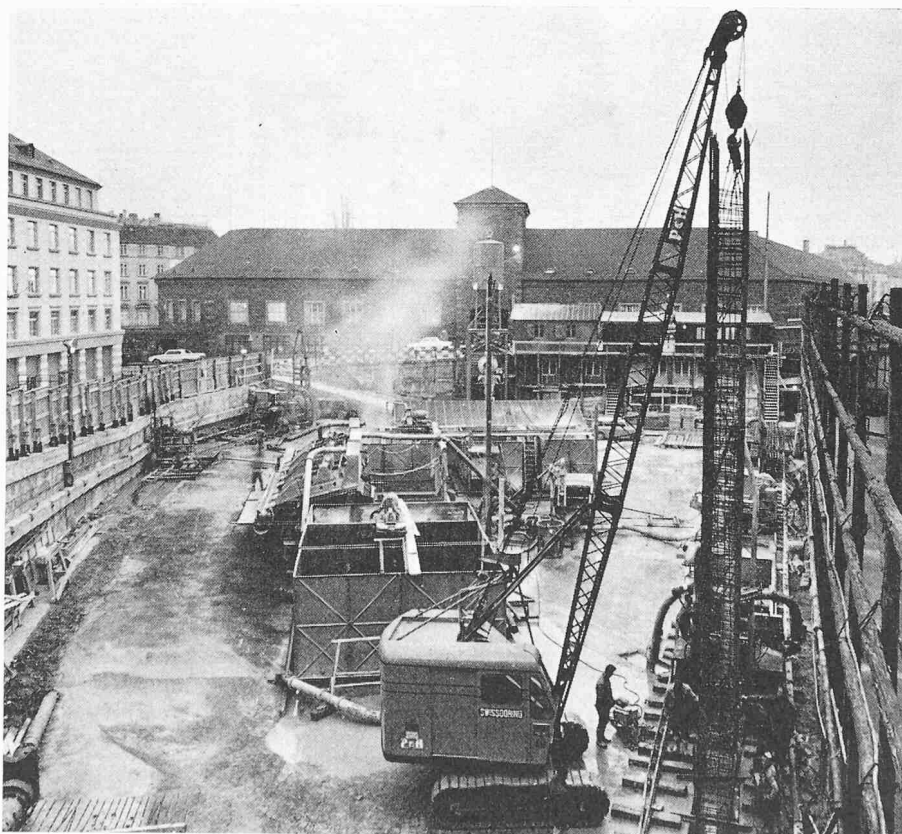
Bild 35. Übersicht der Schlitzwandbaustelle mit Armierungseinbau
