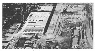
Deutschland — Flughafen Hamburg, Luftfrachtgebäude Verhütung von Beschädigungen durch Dacharbeiten: 10 000 m² Roofmate wurde beim Bau des Luftfrachtgebäudes des Flughafens Hamburg verwendet. Roofmate wurde besonders deshalb gewählt, weil es gegen die Feuchtigkeitseinwirkung, wie sie bei umfangreichen Dachbauarbeiten entsteht, unempfindlich ist.
