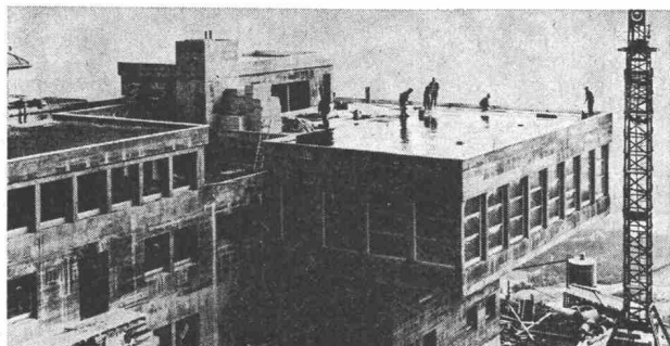
Schweiz — Bergstation Corviglia 2500 m.ü.M. Raues Klima: Roofmate wurde zur Dachisolation in der Bergstation Corviglia verwendet. Hier war wesentlich, dass Material verwendet wurde, das den schlimmsten Wetterverhältnissen widersteht.
