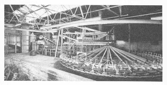
Bild 1. Vollständige, automatische Owen-Hallsworth-Formanlage in einer englischen Giesserei
