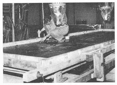
Bild 3. Einsetzen der Haftanker in die Konstruktionsbetonplatte unmittelbar vor dem Einbau des Betondeckbelages (Winkelschrauben M 12 in Steinschraubenhülsen M 12  $\times$  60)
