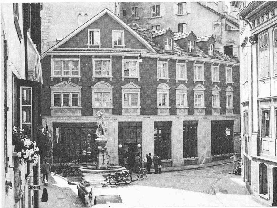
Umbau «Kantorei» Bauherr: Verein Verbindungshaus Zürcher Singstudenten Architekt: SIA Karl Knell BSA/SWB Wolfgang Behles
